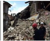
Terremoto, sopralluogo di Rossi ad Amatrice
